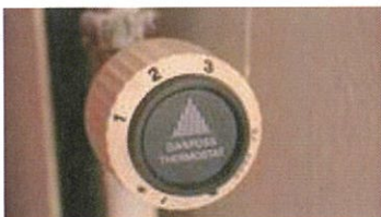
Kuva huoneiston patteriventtiilistä. Voi olla asuntokohteessasi myös hieman eri näköinen.
